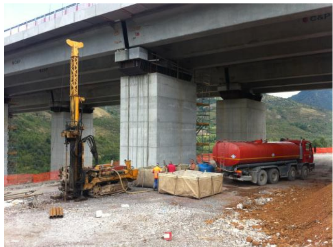
Perforazione per installazione piezometri e inclinometri da foro
